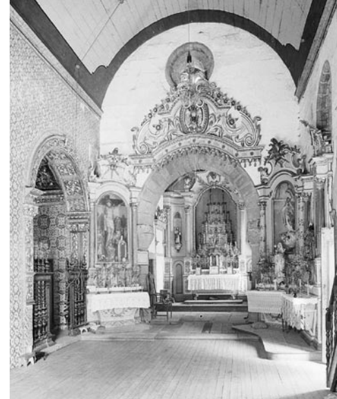
13. Interior da Igreja antes do restauro.
