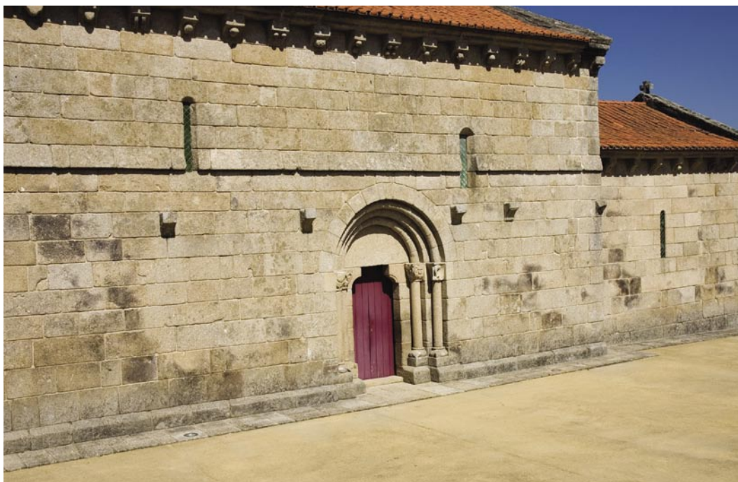
9. Fachada sul. As mísulas e o lacrimal, destinado ao escoamento das águas pluviais, indiciam a existência de um alpendre com telhado de uma água.
