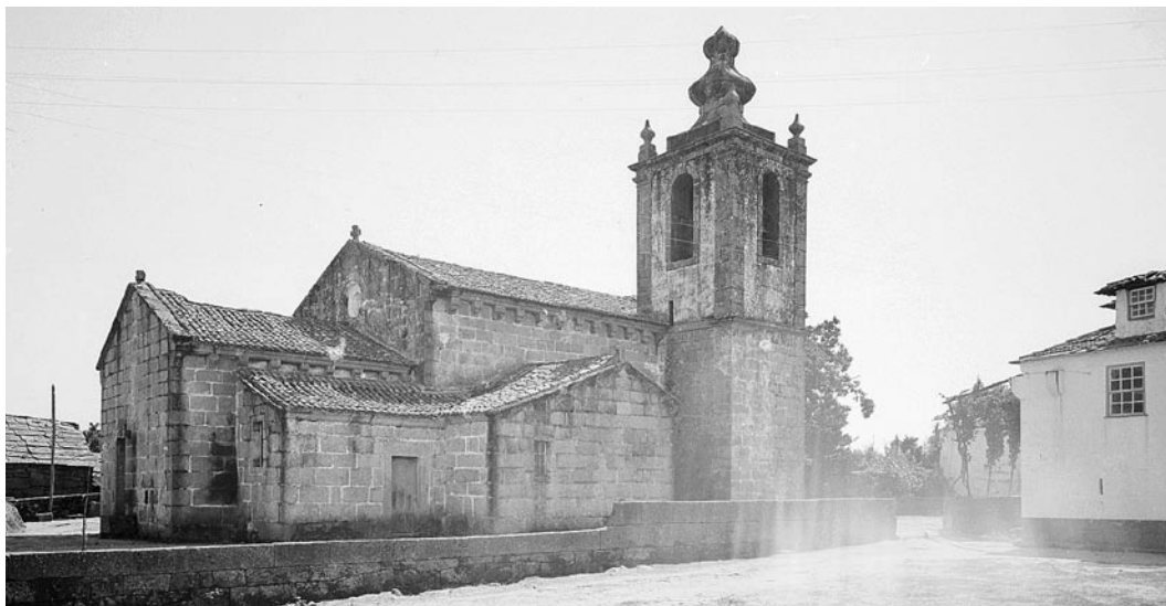
18. Igreja do Salvador de Cabeça Santa antes do restauro.
