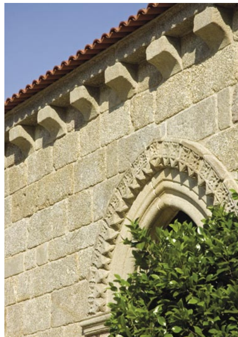
8. Fachada sul. Portal rematado por decoração própria do séc. XIV.
