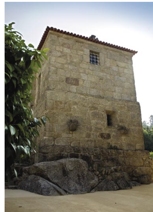
9. A ampliação da cabeceira foi edificado sobre um afloramento granítico.
