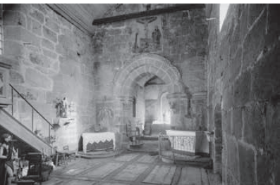
Nave antes das intervenções da DGEMN. Fonte: arquivo IHRU.
