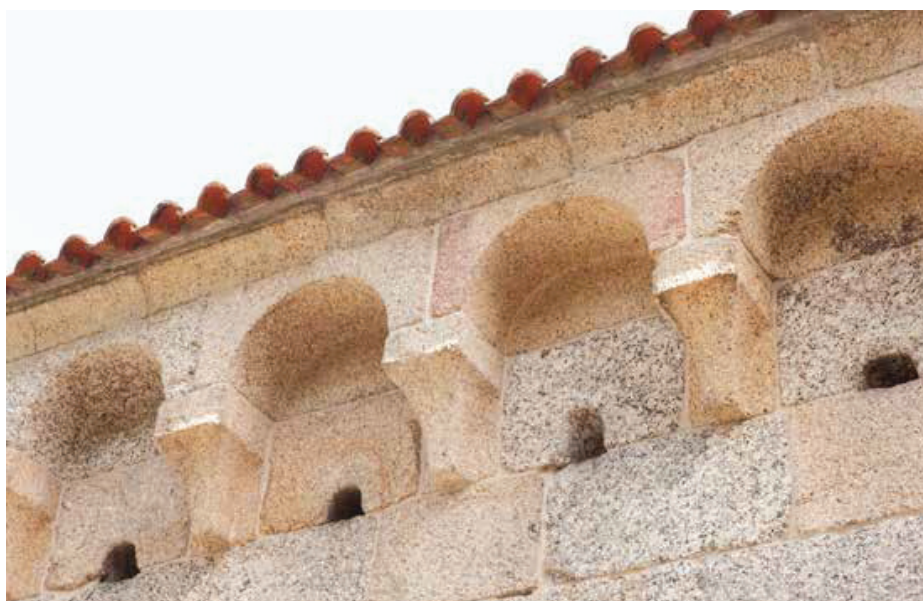
Fachada norte. Capela-mor. Cornija.
