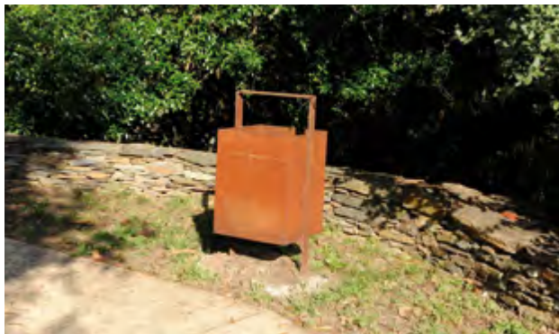
Muro de contenção de terras com altura para assento e mobiliário urbano.
