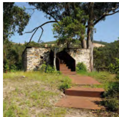
Pavimento exterior em aço corten-a.
