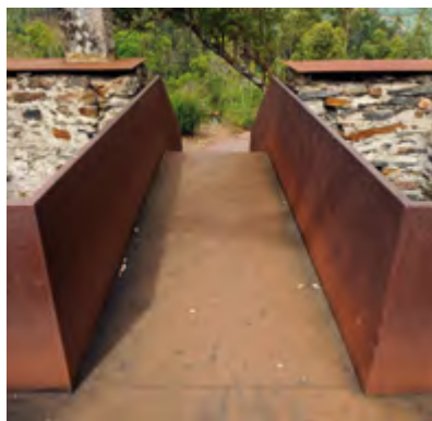
“Passadiço em ponte” de acesso ao interior da Torre do Castelo de Aguiar de Sousa.
