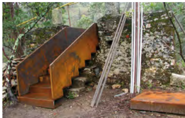
Estrutura de acesso ao varandim.
