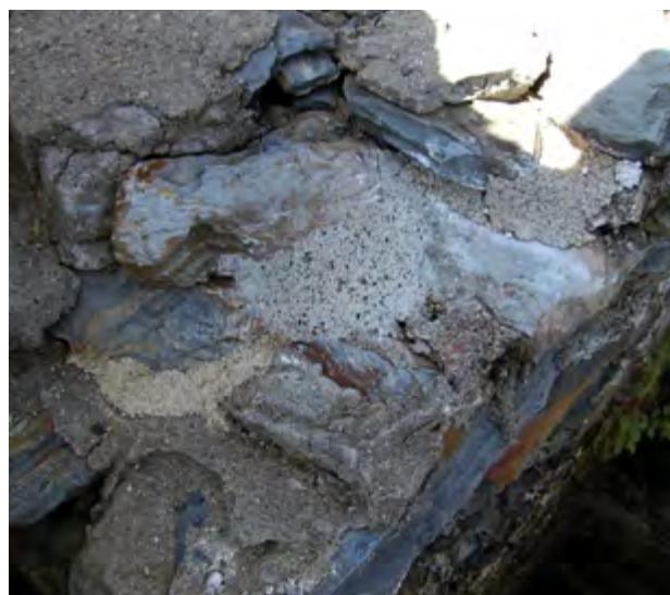
Pormenor dos testes de argamassas.
