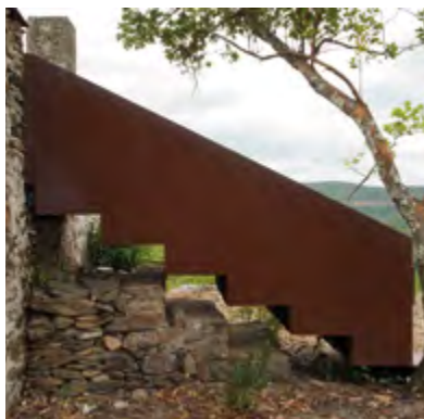
Escadas interligadas ao “passadiço”.
