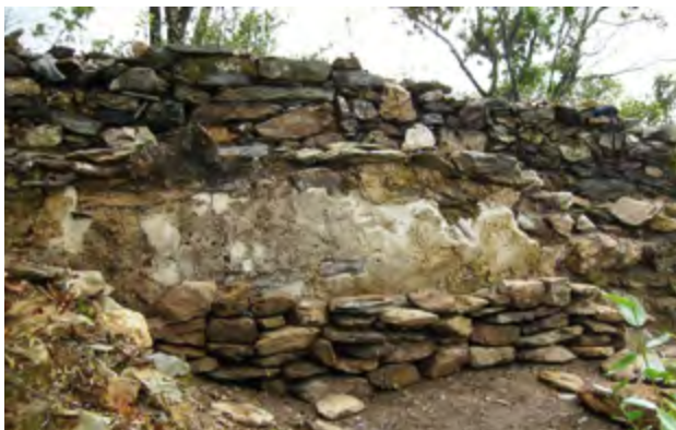
Início da construção do muro de proteção.
