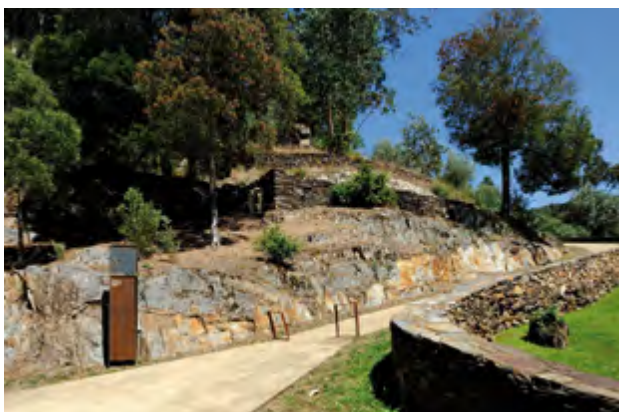
Pavimento destinado ao acesso pedonal em saibro/solo-cimento.
