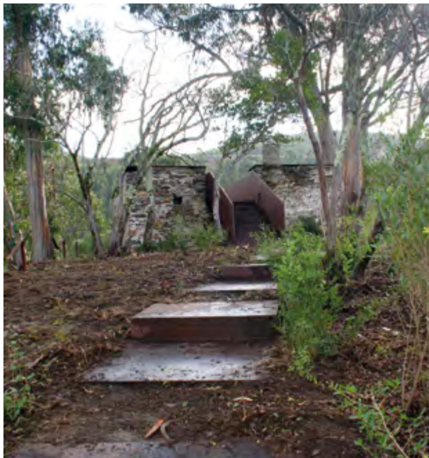
Torre do Castelo de Aguiar de Sousa em 2011. Trabalhos de manutenção.
