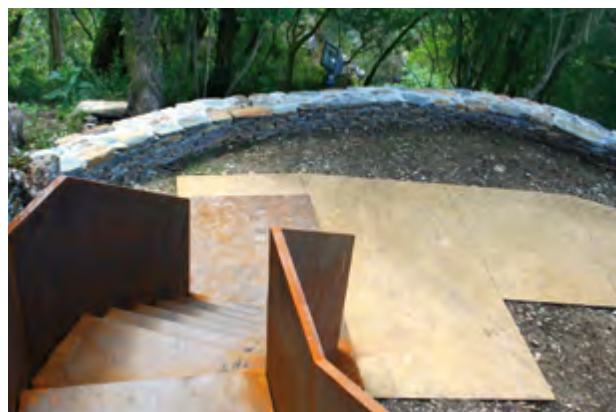
Acesso às escadas.
