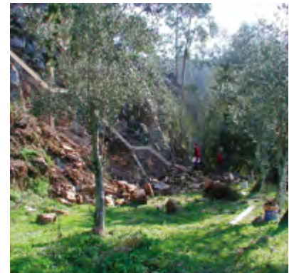
Acompanhamento em obra da execução da estrutura metálica da escadaria.
