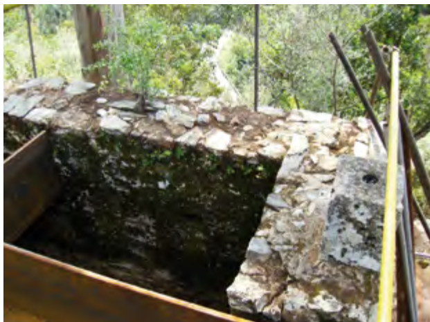
Pormenor da ameia preservada no local.
