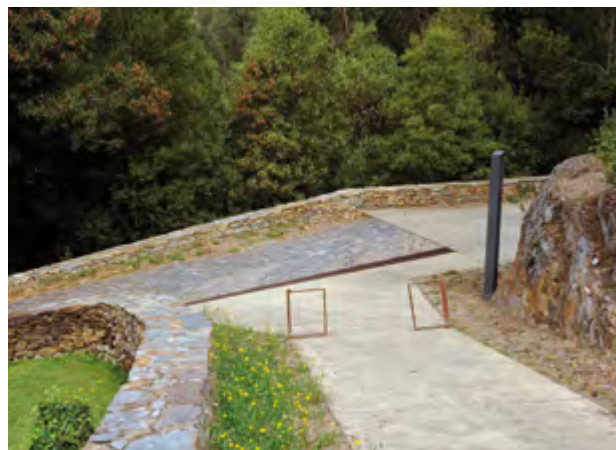
Caminho de acesso à Torre. Confluência do pavimento destinado ao acesso automóvel com o pavimento para acesso pedonal.
