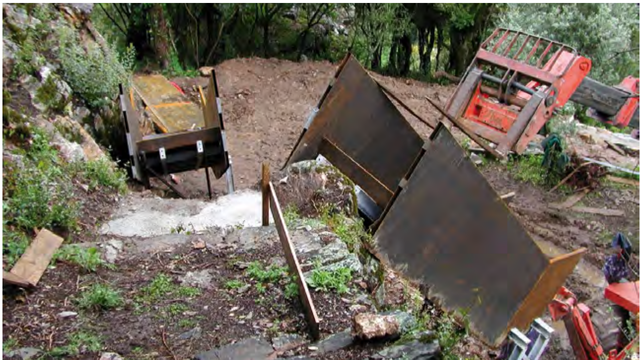
Acompanhamento da obra, aferindo in loco a estrutura projetada.
