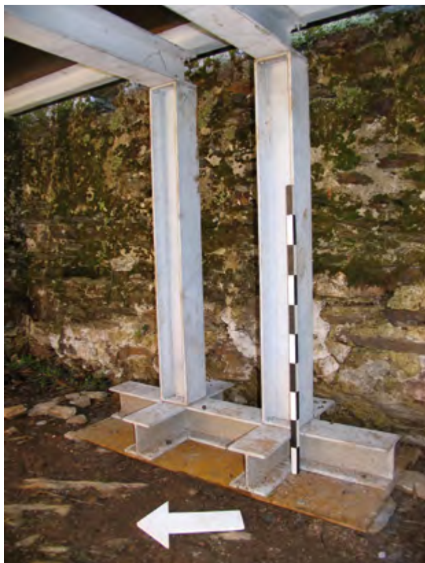
Estrutura do varandim da Torre.
